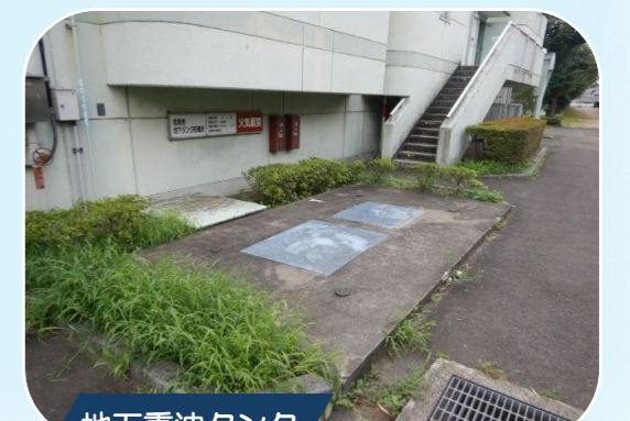
地下重油タンク
