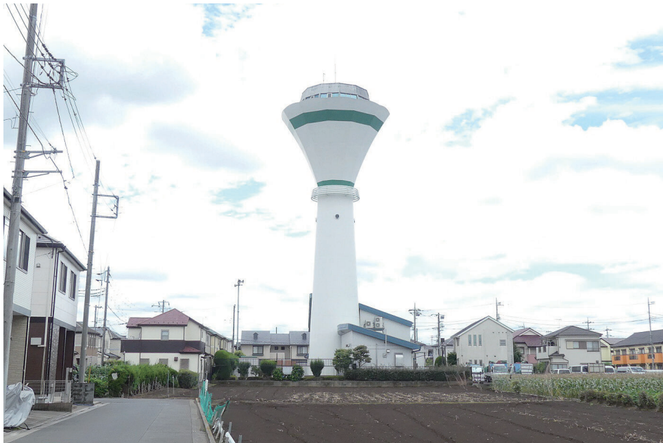
鶴瀬西配水場
