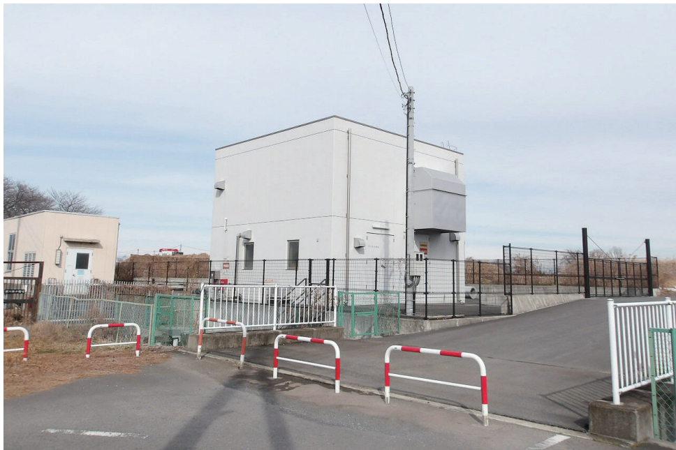
凶川排水機場
