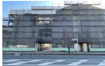
工事中の西交流センター
